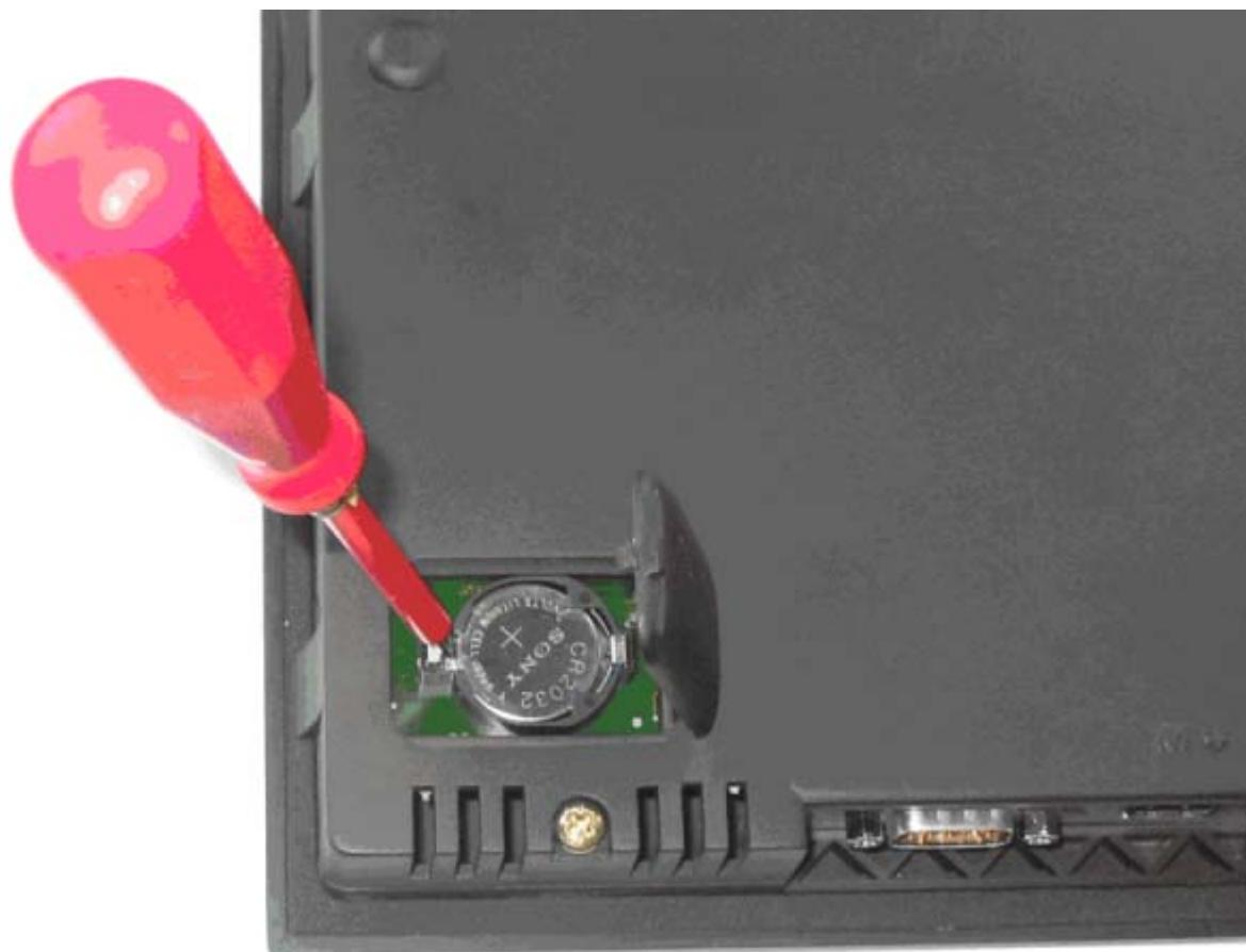
Изображение 11-21 Замена буферной батареи на панели управления шкафа.
